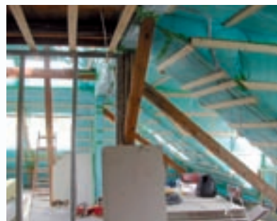
Le niveau étanche (film et panneaux bois) est encore visible. C'est le moment idéal pour un test BlowerDoor.
